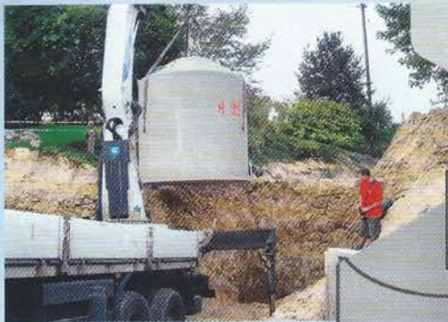
Ein Kran hebt die 9000 Liter fassende Zisterne in das vorbereitete Erdloch. Schäfer baute zeitgleich eine Dreifachgarage – nur deshalb waren die Bauarbeiten so umfangreich
