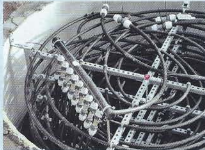
Li.: Die Zisterne von innen, durch die Rohre fließt Kühlflüssigkeit O.: Früher standen in Schäfers Keller drei Tanks für Heizöl. Heute brauchen Wärmepumpe und Warmwasserspeicher viel weniger Platz
