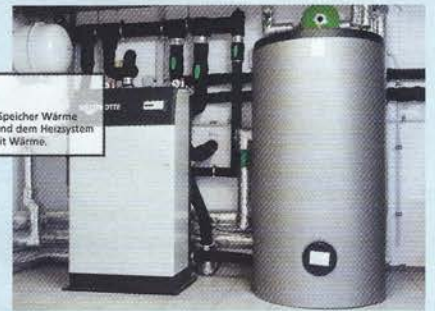
Li.: Die Zisterne von innen, durch die Rohre fließt Kühlflüssigkeit O.: Früher standen in Schäfers Keller drei Tanks für Heizöl. Heute brauchen Wärmepumpe und Warmwasserspeicher viel weniger Platz
