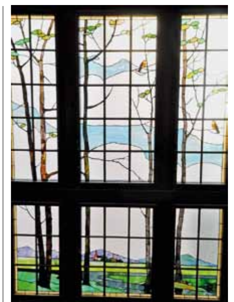
Eines der Fenster im Treppenhaus deutet es an: Bauphysikalisch tat man sich schwer, die denkmalgeschützte Villa aus den 1920-er Jahren energetisch zu sanieren. Die Wärmepumpen-Technik musste einspringen, um EnEV-Konformität zu erreichen
