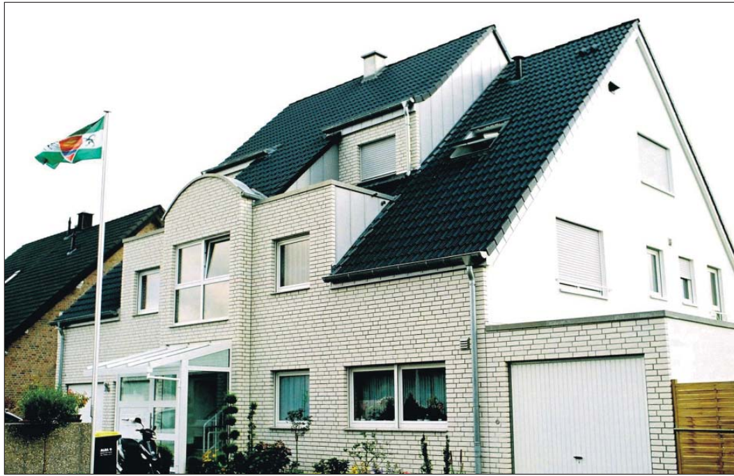
KfW-60-Vierfamilienhaus mit jährlichen Belastungen, die einem konventionellen EnEV-Gebäude entsprechen, obwohl der Wärmebedarf um 50 Prozent gesenkt wurde.
