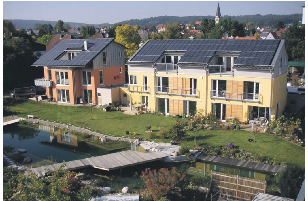
Schartenbergstraße Kassel. Zum Objekt gehört noch ein Einfamilienhaus auf der anderen Seite des Schwimmteichs und ein sanierter Altbau quer vor der rechten Stirnseite des Doppelhauses.
