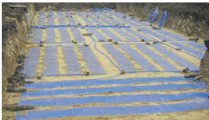
Verlegung der wasserdurchflossenen Kunststoffmatten in 1,50 m Tiefe. Die zirkulierende Sole (Wasser/Glycol) nimmt die Erdwärme auf und gibt sie über Wärmepumpe und Fußbodenheizung an die Zimmer ab.
