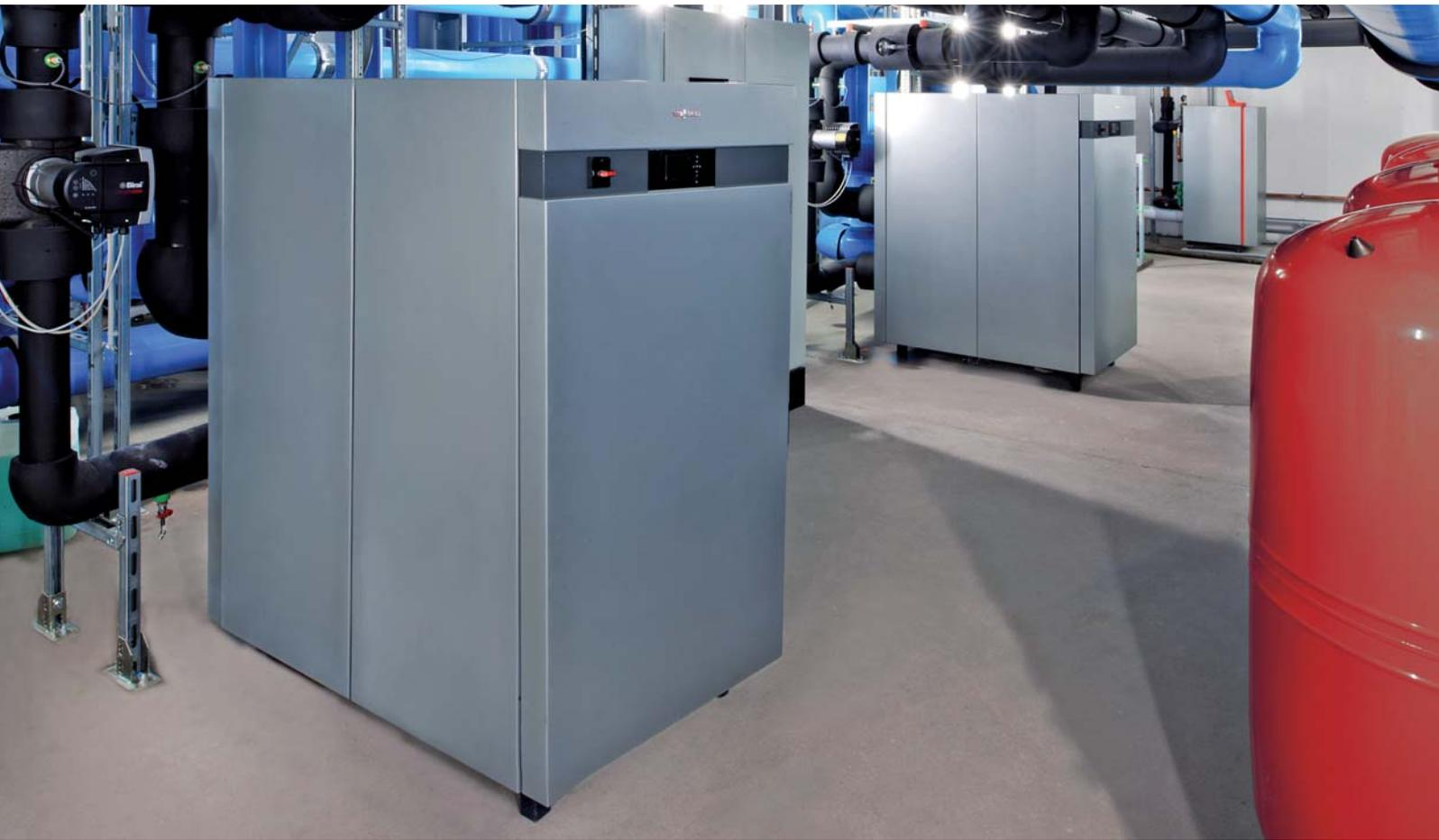
Zwei Wärmepumpen Vitocal 300-G Pro mit je 120 kW Leistung, im Hintergrund ein Gas-Brennwert-Spitzenlastkessel Vitocrossal 300.
