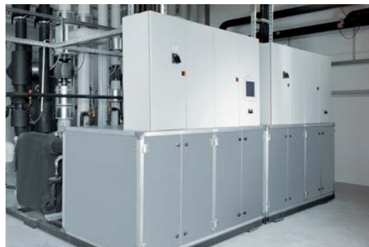
Zwei Luft/Wasser-Großwärmepumpen
