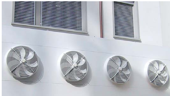
Glykol-Rückkühler als integrierte Fassadenlösung für Luft/Wasser-Wärmepumpen
