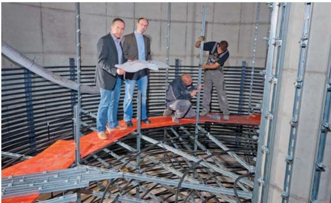
Verlegen der ringförmigen Wärmetauscher im Eis-Energiespeicher. Der Durchmesser beträgt 10 m, die Höhe 6 m.
