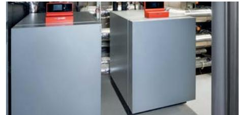
Zwei Wärmepumpen Vitocal 300-G gewinnen Wärme und Kälte aus einem Eis-Energiespeichersystem.
