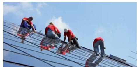
Dach mit Doppelfunktion: Unter den PV-Modulen sind die Leitungsstränge des Solar-Luftabsorbers verlegt.
