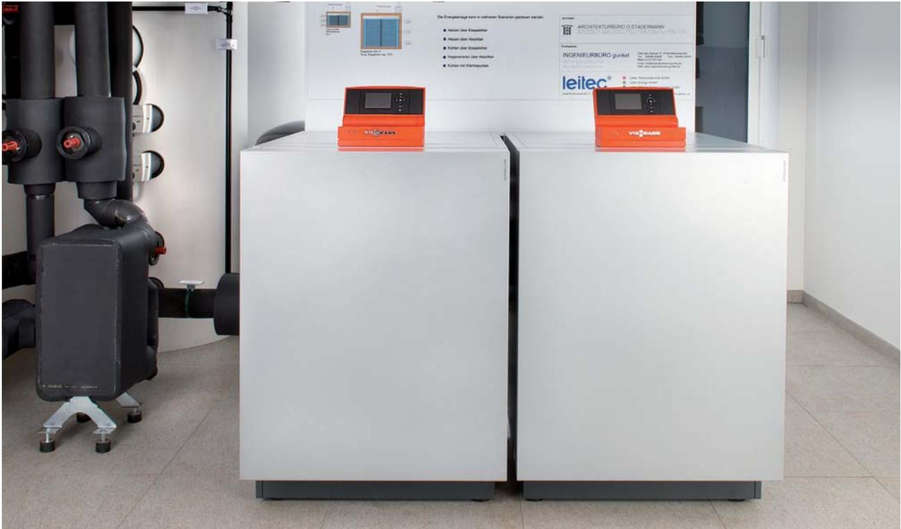
Zwei Sole/Wasser-Wärmepumpen Vitocal 300-G mit einer Gesamtleistung von 64 kW.
