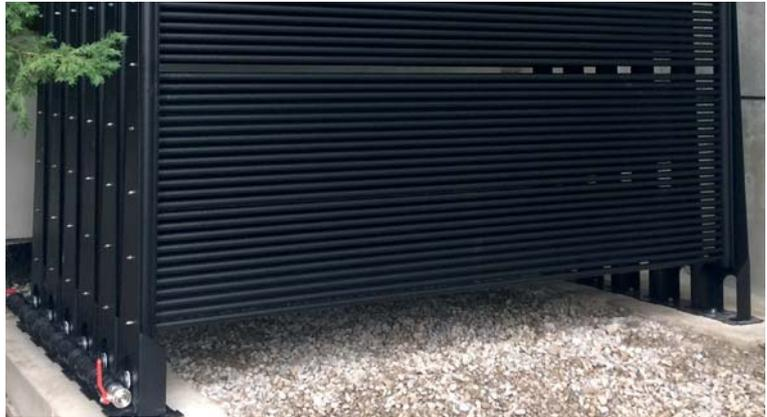
Solar-Luftabsorber in Form eines Energiezauns. Die kompakte Anordnung der einzelnen Module benötigt nur wenig Platz.
