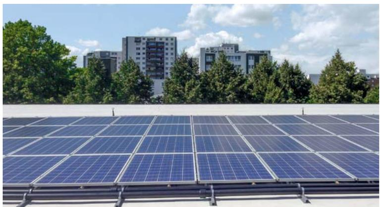
Thermische und elektrische Energie können mit einem speziellen PVT-Modul auf ein- und derselben Fläche gewonnen werden.
